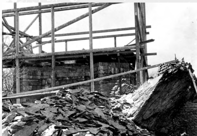
Stavba rozhledny na vrchu Háj – základy s lešením, r. 1902–1903
