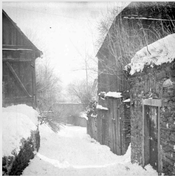
Pohled ke kamennému mostu
